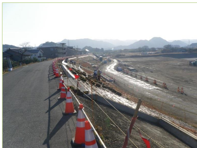
恒富地区堤防浸透対策工事
