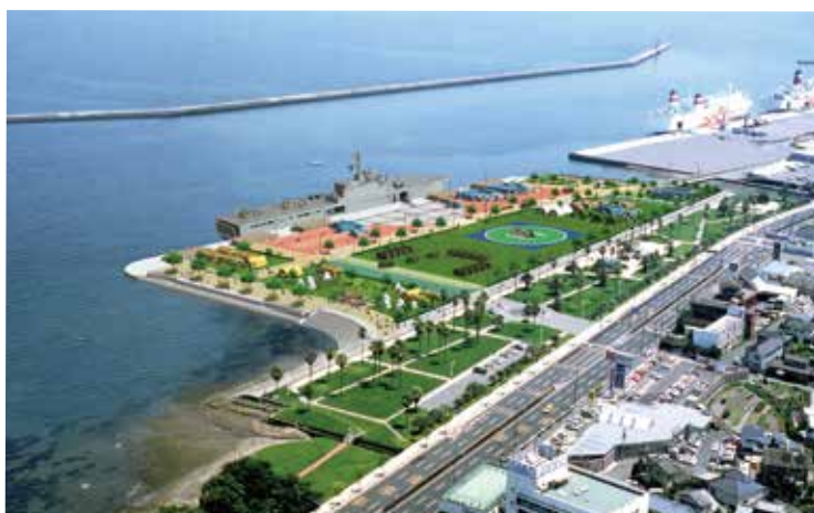
▲耐震強化岸壁（写真提供：別府港湾・空港整備事務所）
