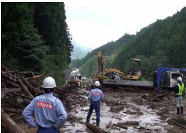
▲国道 211 号道路啓開状況 (H29.7 九州北部豪雨 東峰村)
