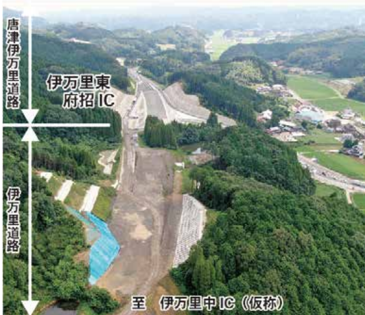
▲西九州自動車道
