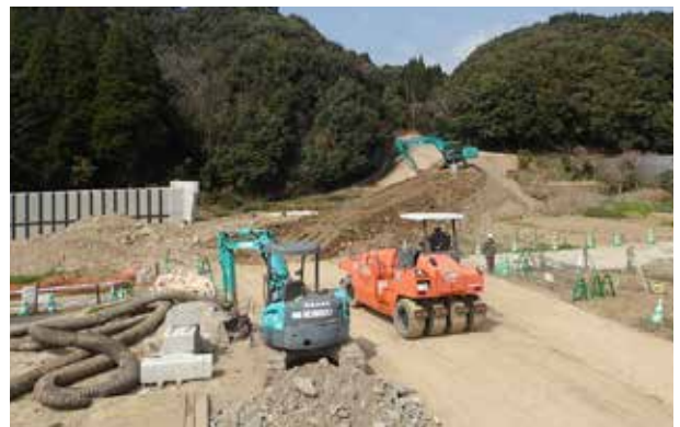
▲西九州自動車道(白野地区)
