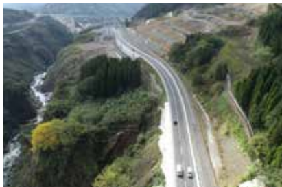
▲国道57号開通状況
