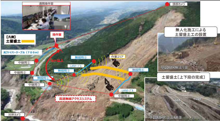
▲緊急復旧工事（無人化施工による土留盛土設置等）
