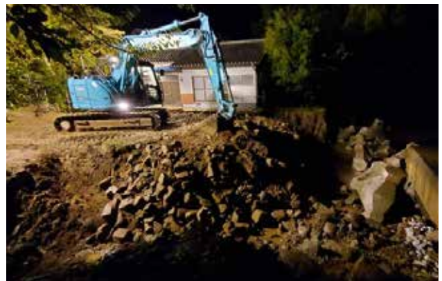
▲災害復旧工事
