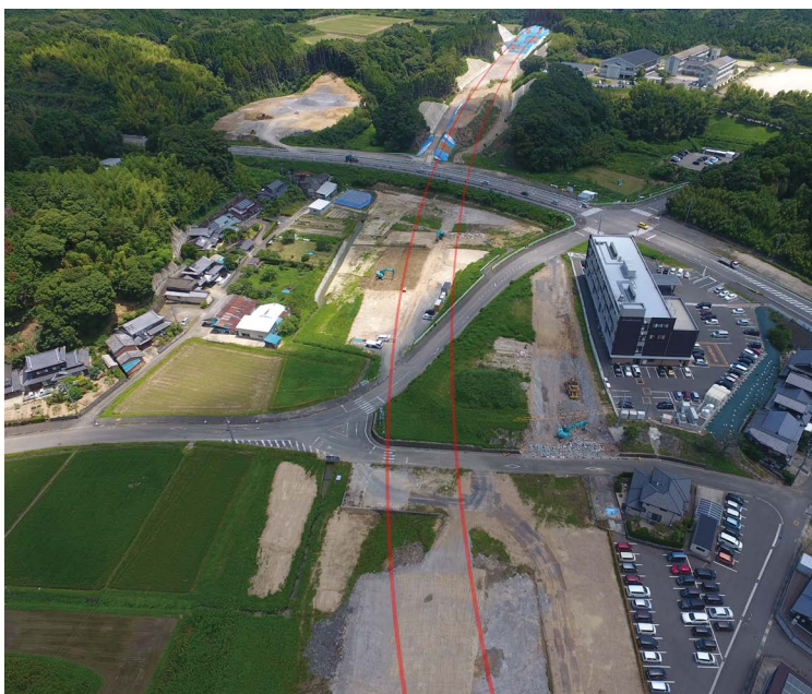
▲西九州自動車道建設事業（佐賀497号木須地区東工区改良工事）
