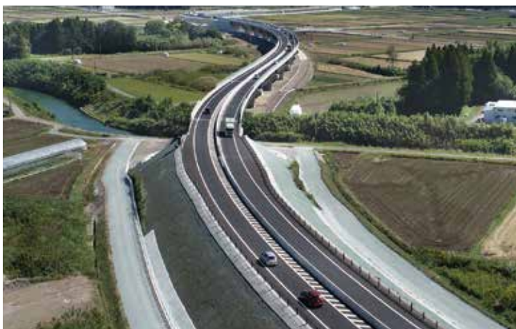
▲令和2年10月に開通した国道57号北側復旧ルート（黒川橋）
