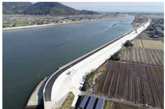
▲高潮対策：沖新地区完成（全景）
