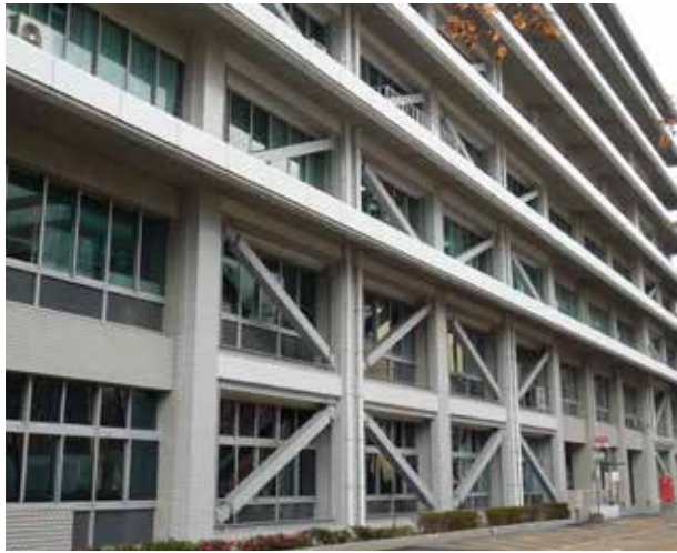
▲福岡第一合同庁舎（耐震ブレース）
