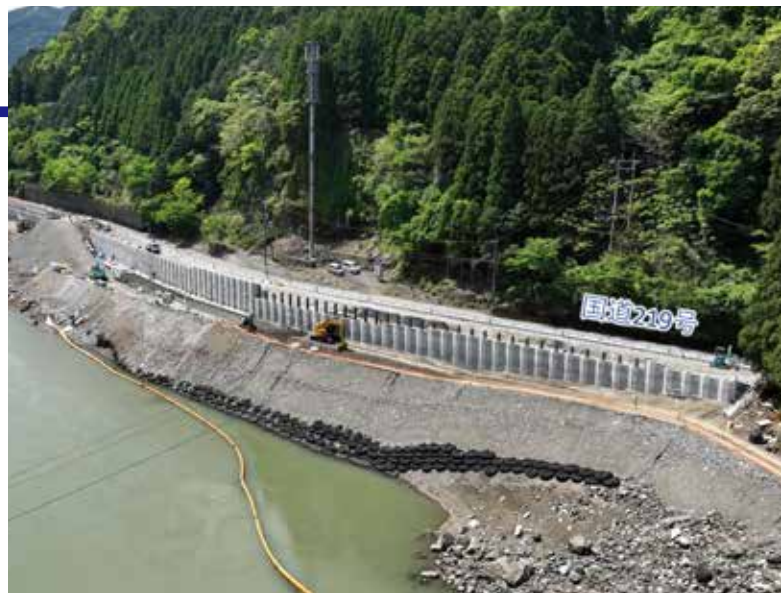
▲施工状況(道路の高上げ)
