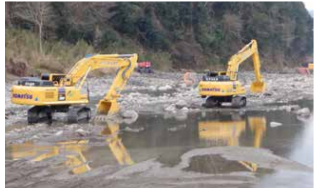
▲球磨川本川掘削状況
