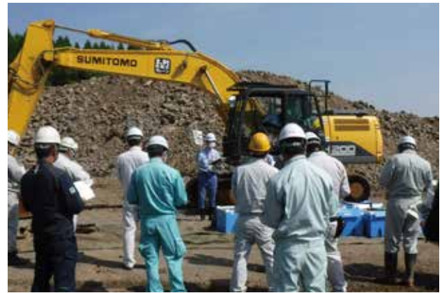
▲無人化施工訓練
