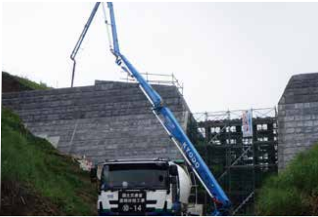
▲スランプ8のコンクリートを使用したポンプ車打設
