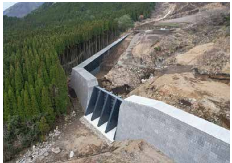
▲令和5年3月に完成した上の小屋川2砂防堰堤
