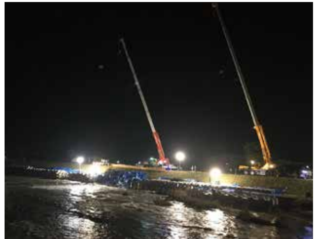
▲稼働掘削作業
