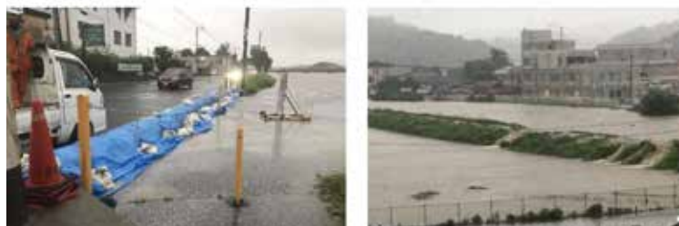
▲平成30年7月豪雨の出水状況
