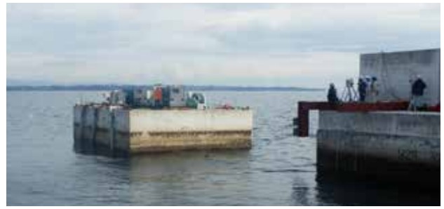
▲ケーソン据え付け
