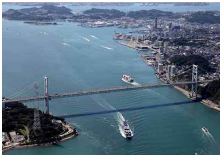
▲関門橋付近の関門航路
