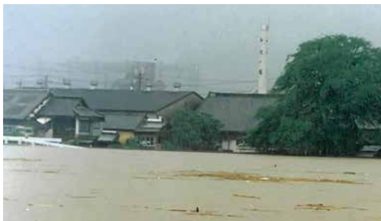
▲山鹿特殊堤・パラペット天端まで約15cmとせまった（平成2年7月出水）
