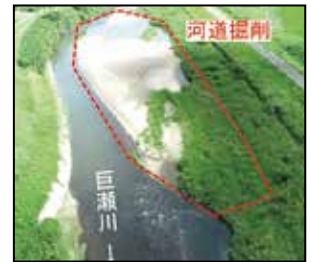
▲河道掘削(巨瀬川)
