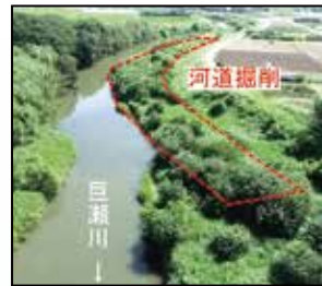
▲河道掘削(巨瀬川)
