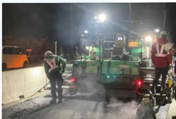
▲舗装修繕、舗設状況
