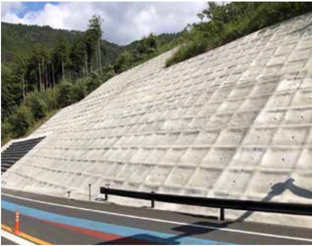
▲法面防災完成
