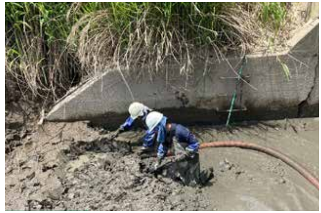
▲ガタ土除去作業
