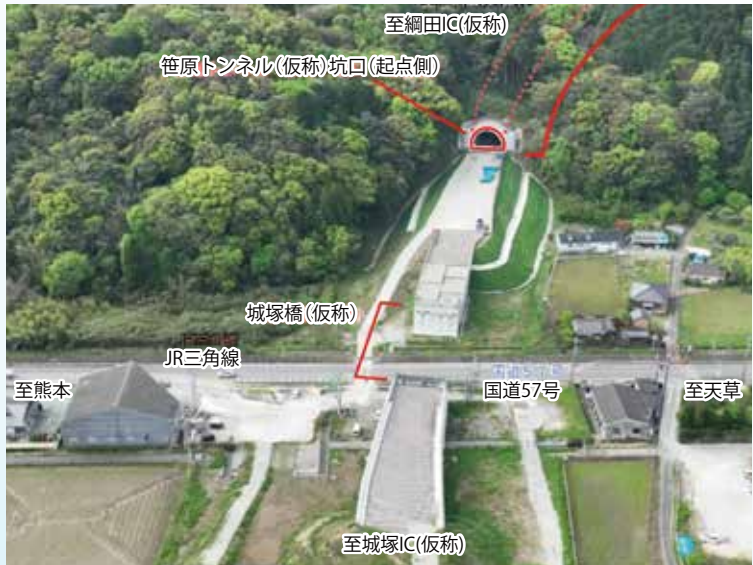
▲熊本天草幹線道路 宇土道路 城塚IC(仮称)
