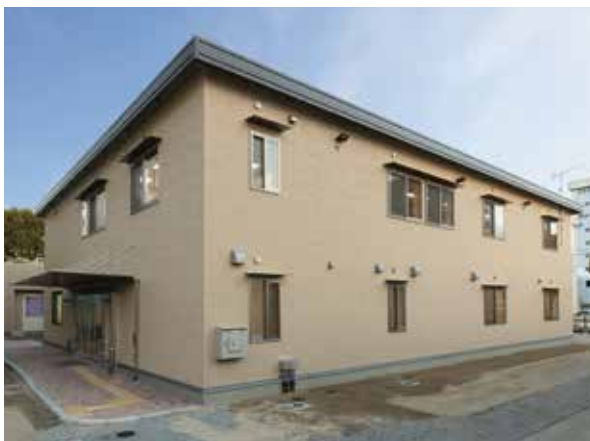
▲土地改良技術事務所(2020年度完成)
