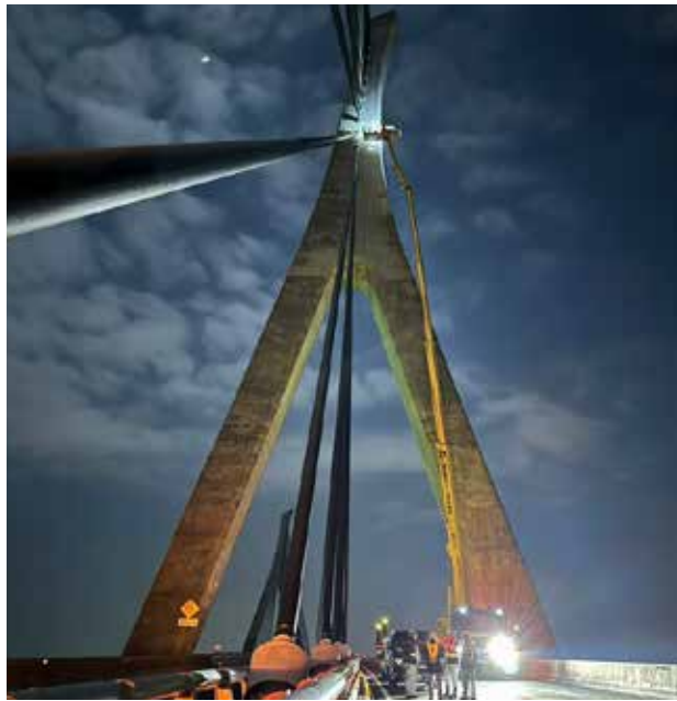
▲矢部川大橋（橋梁点検状況）
