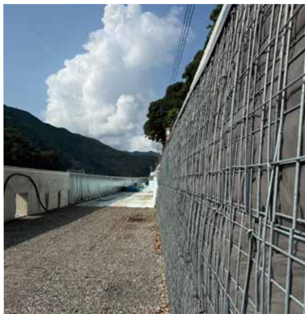
▲道路かさ上げ工事施工状況(坂本地区)
