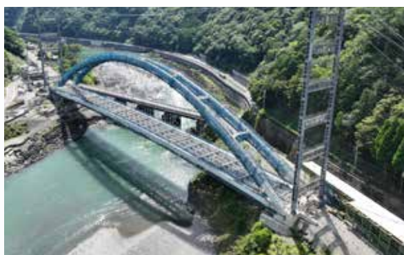
▲国道219号鎌瀬橋施工状況
