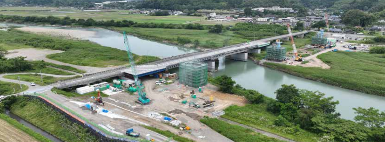
▲県道覚井一武線球磨大橋施工状況
