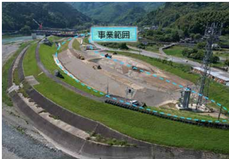
▲災害復旧事業での引堤事業(用地買収箇所)
