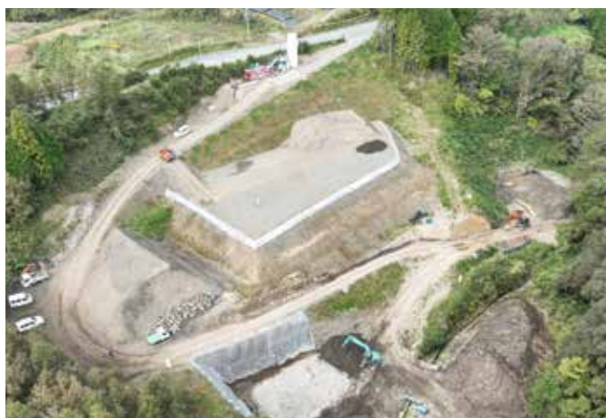
▲九州中央自動車道 蘇陽五ヶ瀬道路 地盤改良近接
