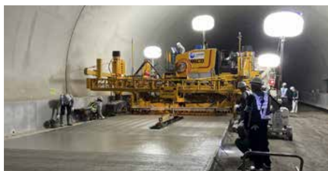
▲中九州横断道路 滝室坂トンネル(仮称)舗装工事の状況
