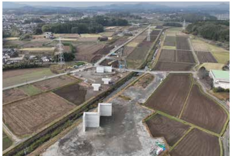
▲中九州横断道路 大津熊本道路(合志～熊本)塩浸川橋下土工
