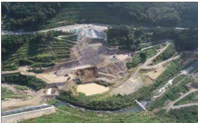
▲本明川ダム本体基礎掘削状況
