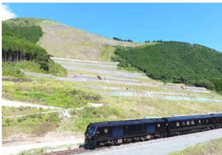
▲阿蘇大橋地区の斜面安定化が完了し復興へさらに前進
